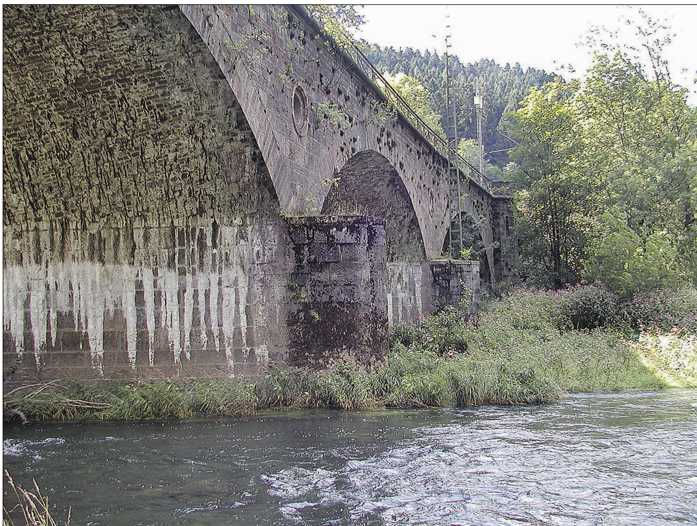
Im Bereich der Sieseler Eisenbahnbrücke fanden Bergungstaucher im Auftrag des Kampfmittelräumdienstes zwei Handgranaten und Infanteriemunition aus dem 2. Weltkrieg. ■ Foto: G. Dickopf
